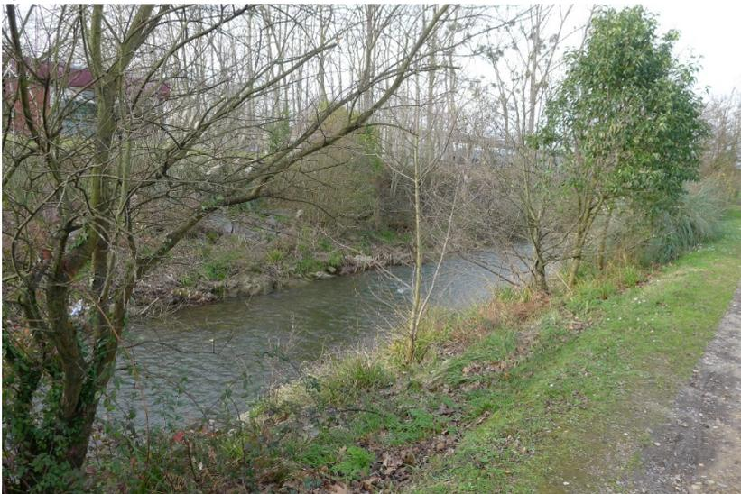
**Figura 18.-** Río Peña Francia. a,b) Vistas del cauce revestido de escollera con trazado natural aguas arriba del anillo (tramo PF 2 Escollera). b) sector del río formando parte del anillo navegable (tramo PF 3 Anillo), donde el cauce ha sido rectificadado y el corredor ripario presenta escasa cobertura.
