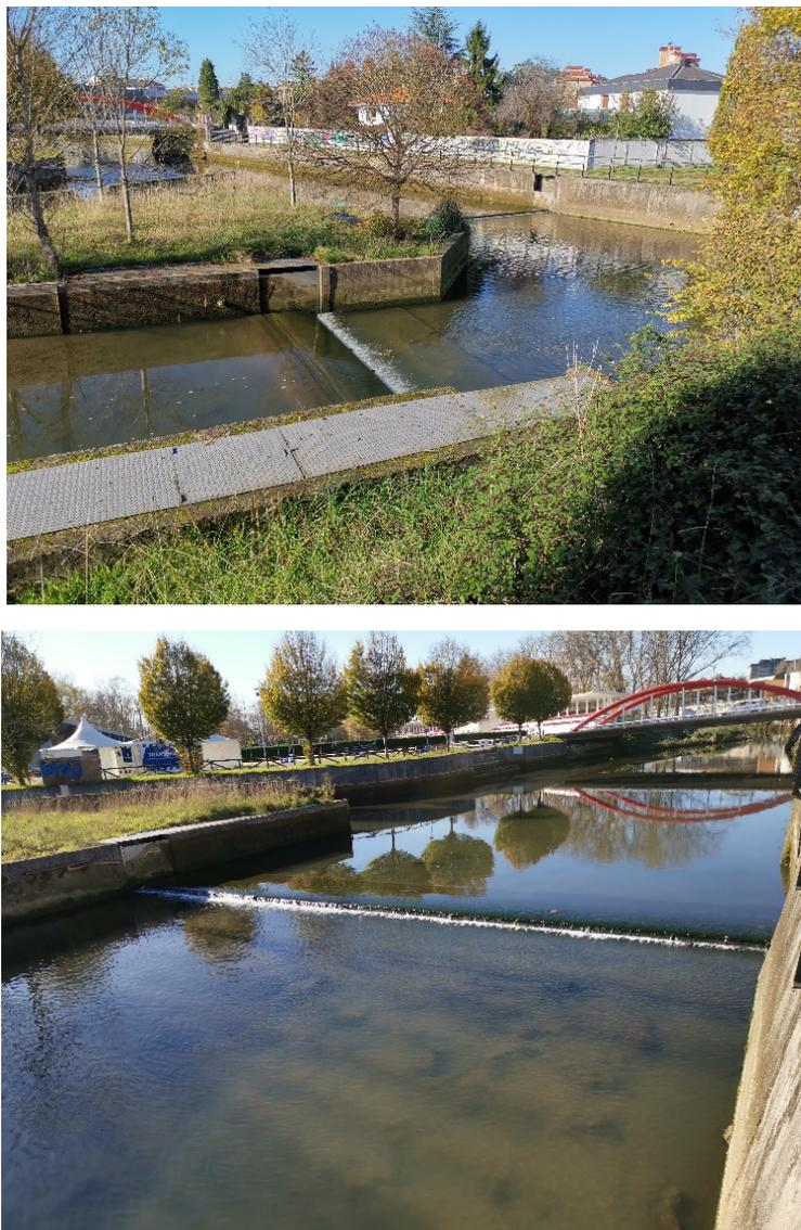
**Figura 2.3.-** Vista general del extremo inferior del anillo navegable, con la presencia de los azudes existentes en los ríos Piles y Peña Francia inmediatamente aguas arriba de su confluencia.
