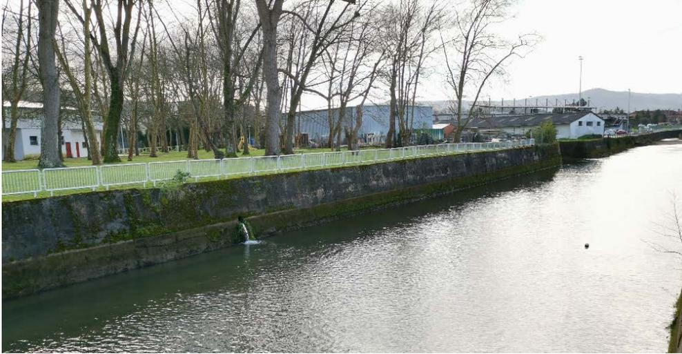
*Figura 3.6.- Margen derecha del río Piles entre Las Mestas y el edificio del Club Covadonga, representativa de los tramos canalizados donde se propone mantener el revestimiento del cauce en su tercio o mitad inferior, y crear por encima taludes abiertos y tendidos en los que se lleven a cabo plantaciones de ribera ampliando las dimensiones del sistema fluvial.*
