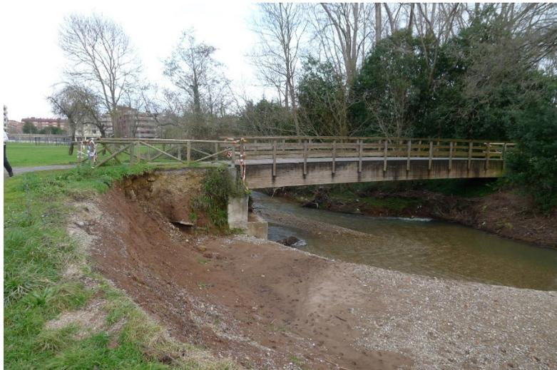
**Figura 3.5.-** Vistas del río Piles atravesando el parque fluvial. a) crecimiento excesivo de zarzales en los sectores menos sombreados, que se pretende controlar con las plantaciones arbóreas propuestas; b) vista de pasarela con erosión de orilla que indica la necesidad de ampliar su vano y mejorar su orientación.
