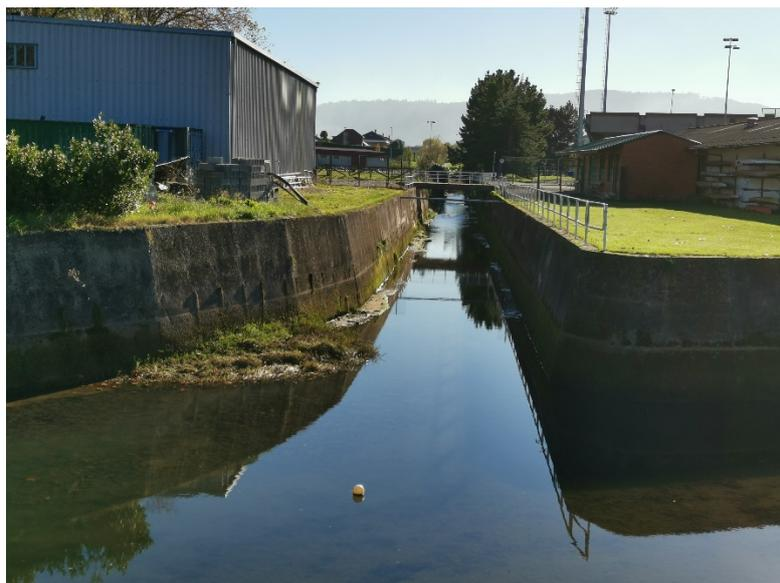
**Figura 3.2.-** Infraestructuras que se propone eliminar para recuperar la continuidad longitudinal de los ríos: a) isleta de orillas hormigonadas y conjunto de azudes en el entorno de la confluencia; b) canal de derivación de aguas del Peña Francia al Piles.
